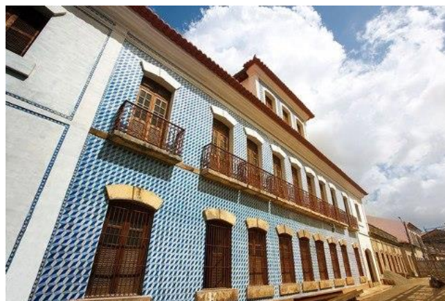
Figura 1. Fachada restaurada da Fábrica Santa Amélia.
