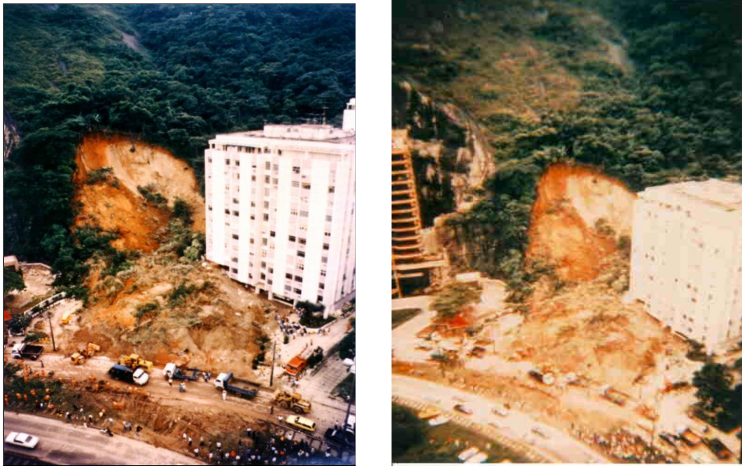
Figura 7 – Detalhes da ruptura da encosta do morro dos macacos
