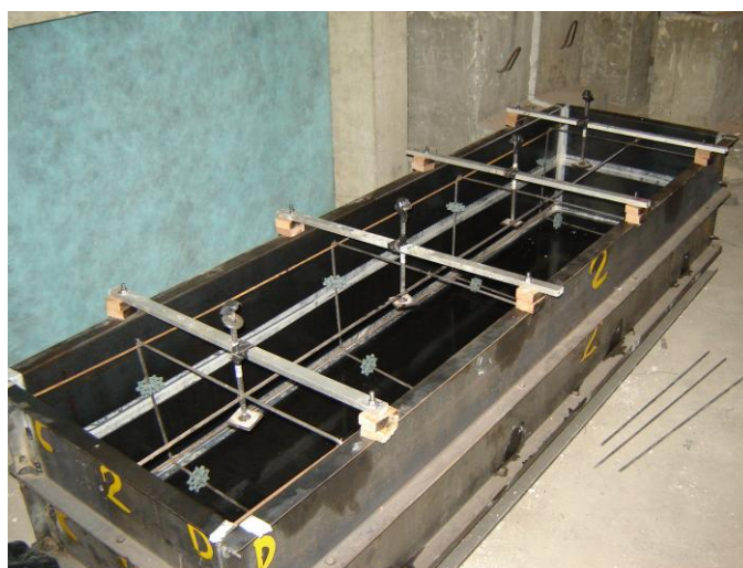
Figura 10. Fôrma pronta para concretagem.
