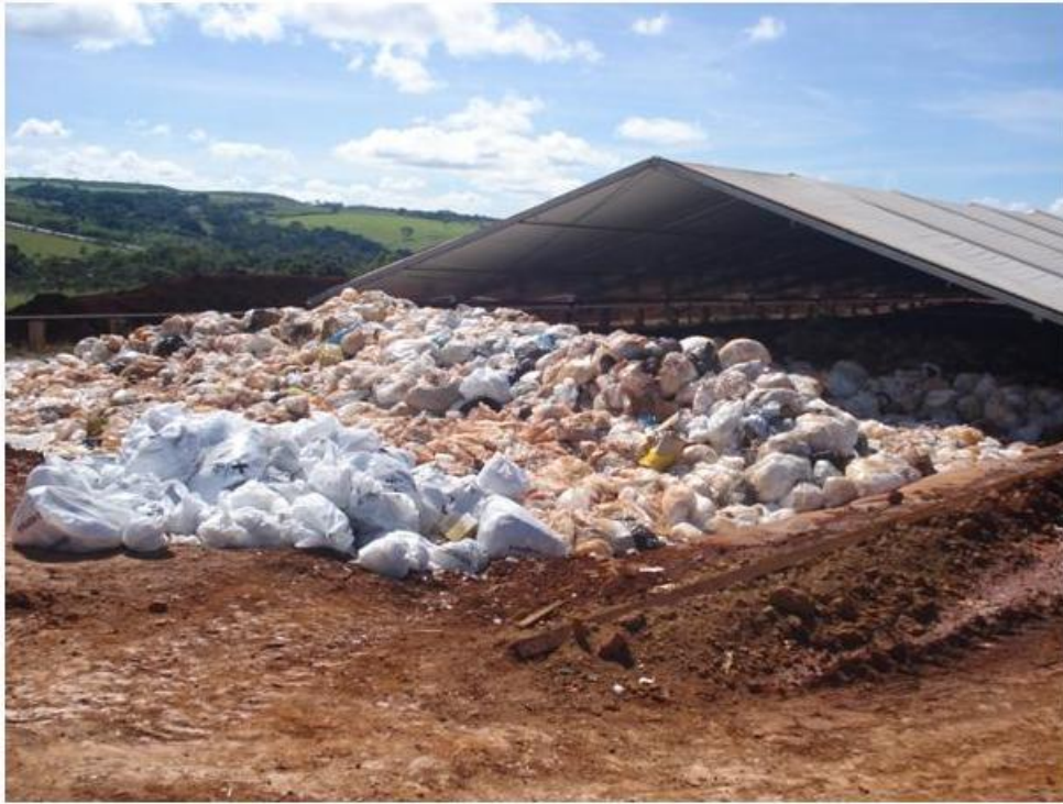
Figura 5: Vala séptica destinada aos resíduos de serviços de saúde.
