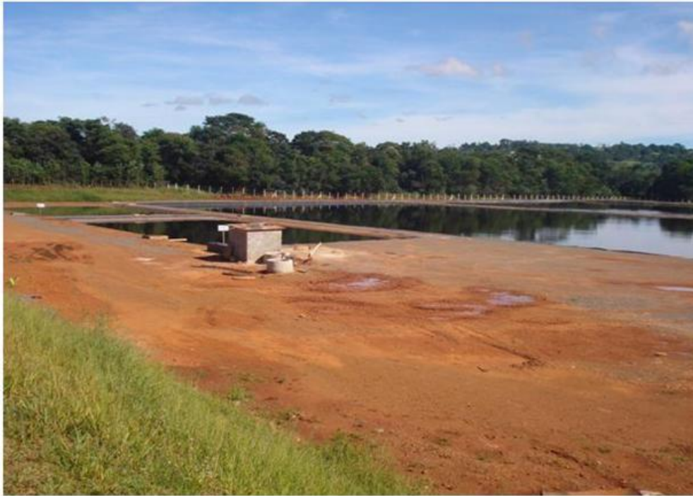
Figura 11: Sistema de tratamento do percolado.
