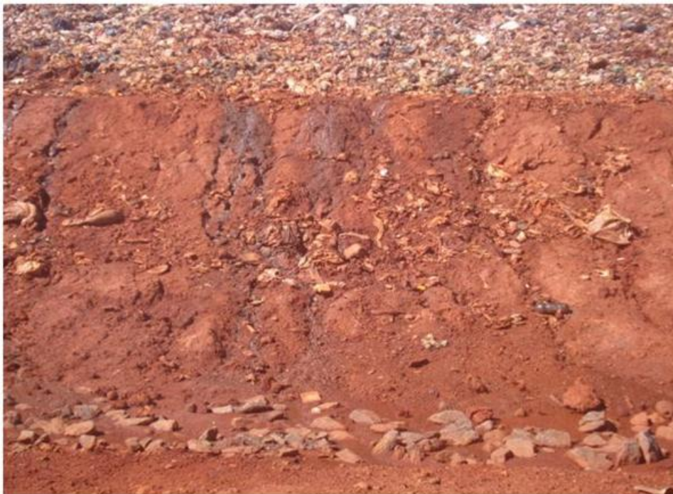
Figura 10: Chorume percolando da célula destinada aos resíduos coletados.
