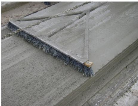
Figura 9 - Detalhe da escova de aço que é arrastada na superfície da laje no momento de sua produção. A imagem mostra claramente a rugosidade antes e depois da passagem da escova.
