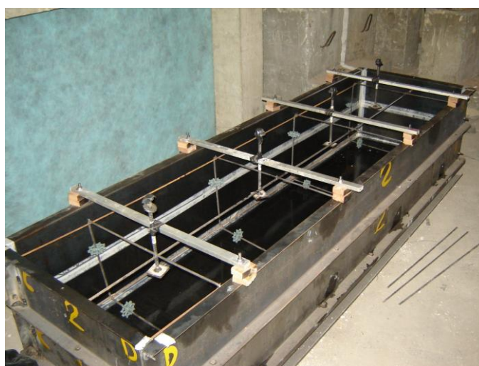
Figura 10. Fôrma pronta para concretagem.
