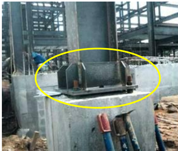
Figura 1. Pino de ancoragem (ligação aço – concreto).
