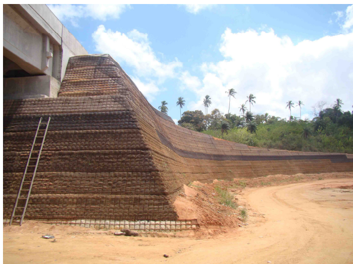
Figura 1 – Estudo de caso: aterro reforçado com geossintético em João Pessoa-PB
